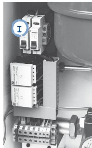
Circuit de puissance de la deuxième allure de chauffe (6 kW)
