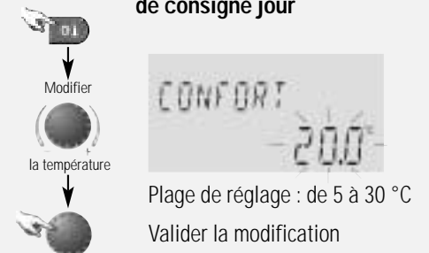
Fig. 1.8 : Température de consigne jour en mode chauffage
