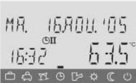
Fig. 1.4a : affichage principal sur la régulation centrale
