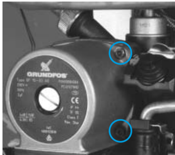
Dépose de la pompe Le moteur de pompe se démonte en dévissant les 4 vis de maintien.
