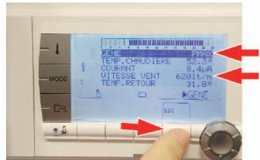
6. Lire la valeur mesurée la plus élevée sur le manomètre pendant le **temps de post-fonctionnement du ventilateur** (brûleur éteint) :
