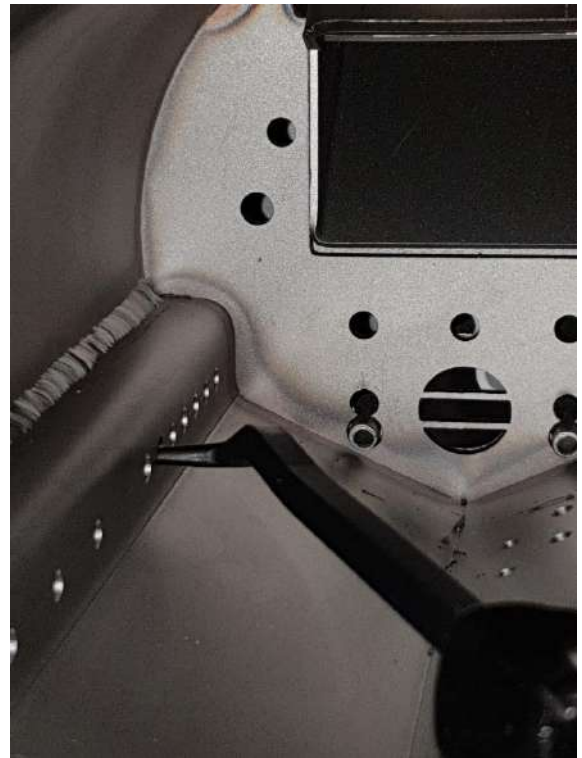
Nettoyage des sorties d'air secondaire. Utiliser les outils livrés avec la chaudière.
