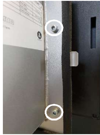
Vis de fixation brûleur sur porte avant.
