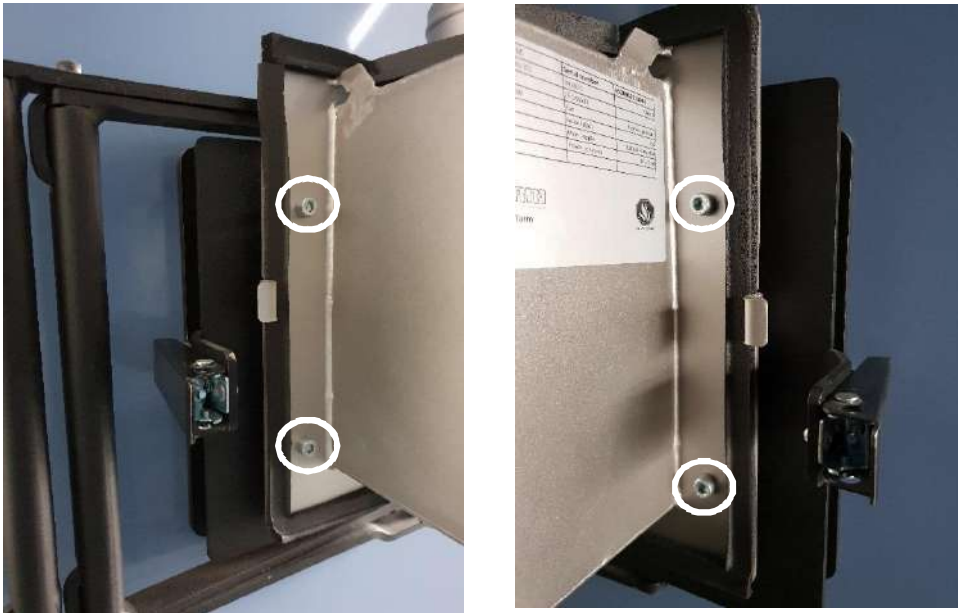
Vis de fixation brûleur sur porte latérale.
