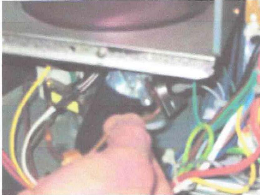
**-déposer les vis de fixation de la protection du brûleur,**
